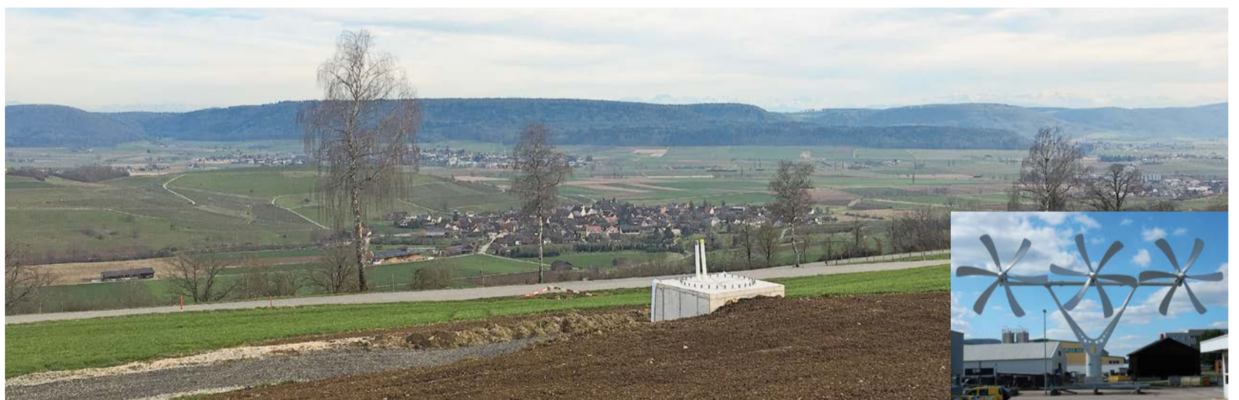
Damit die Baubewilligung nicht verfällt, hat Hansueli Graf im Herbst in Oberhallau den Sockel für «Hans» betoniert, der lange in Beringen stand.
